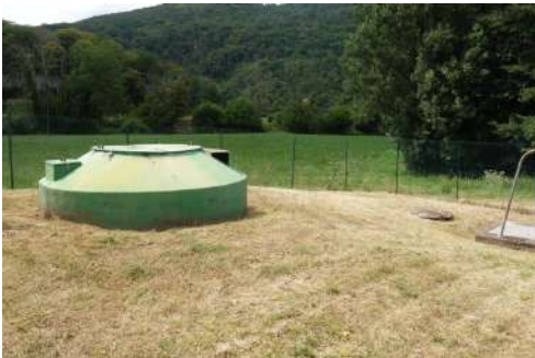
Station d'épuration (STEP) Hyèvre Paroisse
