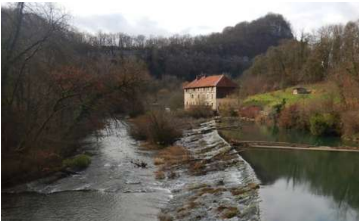
Photo du barrage avant démolition. A droite, la retenue d'eau alimentant le canal.
