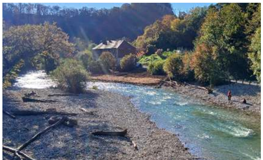
Photo du site après démolition (octobre 2024).
