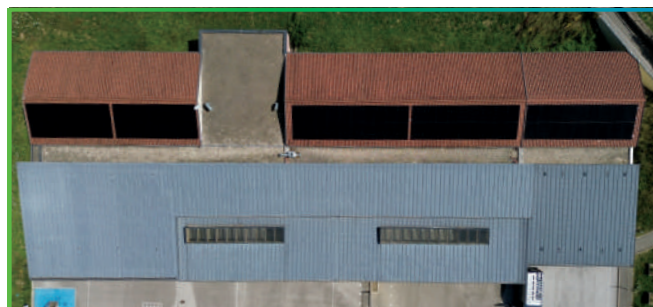
Le Groupe scolaire de La Tour de Sçay Puissance installée : 33,6 kWc
