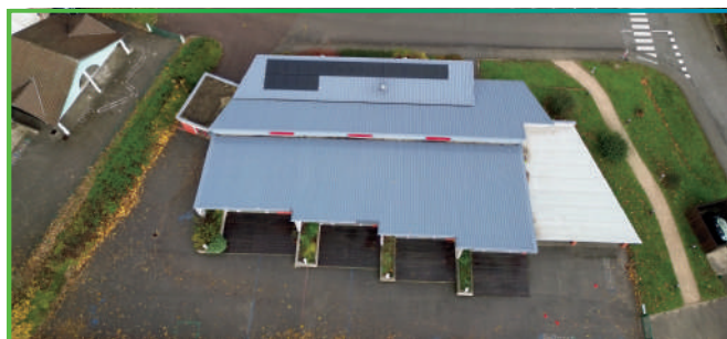
Le Groupe scolaire d'Autechaux Puissance installée : 8,8 kWc
